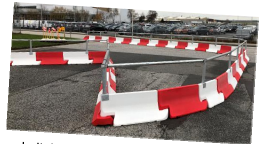
Leitelemente geliefert und aufgestellt
