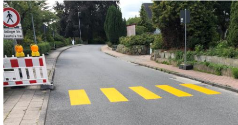
Herstellung eines provisorischen Zebrastrifen aus Fahrbahnmarkierungsfolie
